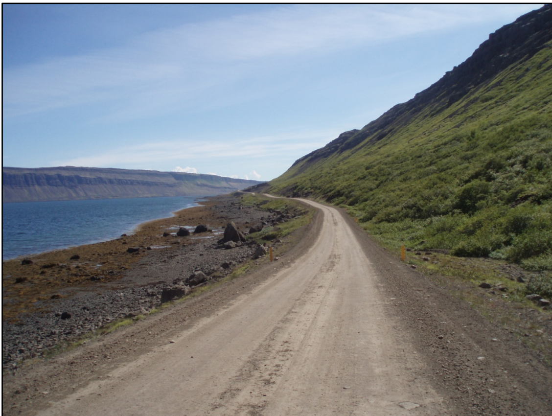
Mynd 4. Núverandi vegur í vestanverðum Mjóafirði, horft út fjörðinn. Stórgrýti í neðri kanti innan öryggissvæðis (Ljósmynd: H.S., 2008).
